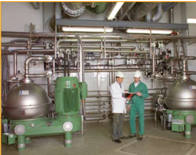
Abbildung 4: Separatoren zur Abtrennung der Hefemilch
